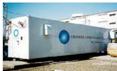
CWCのコンテナ型の局舎
